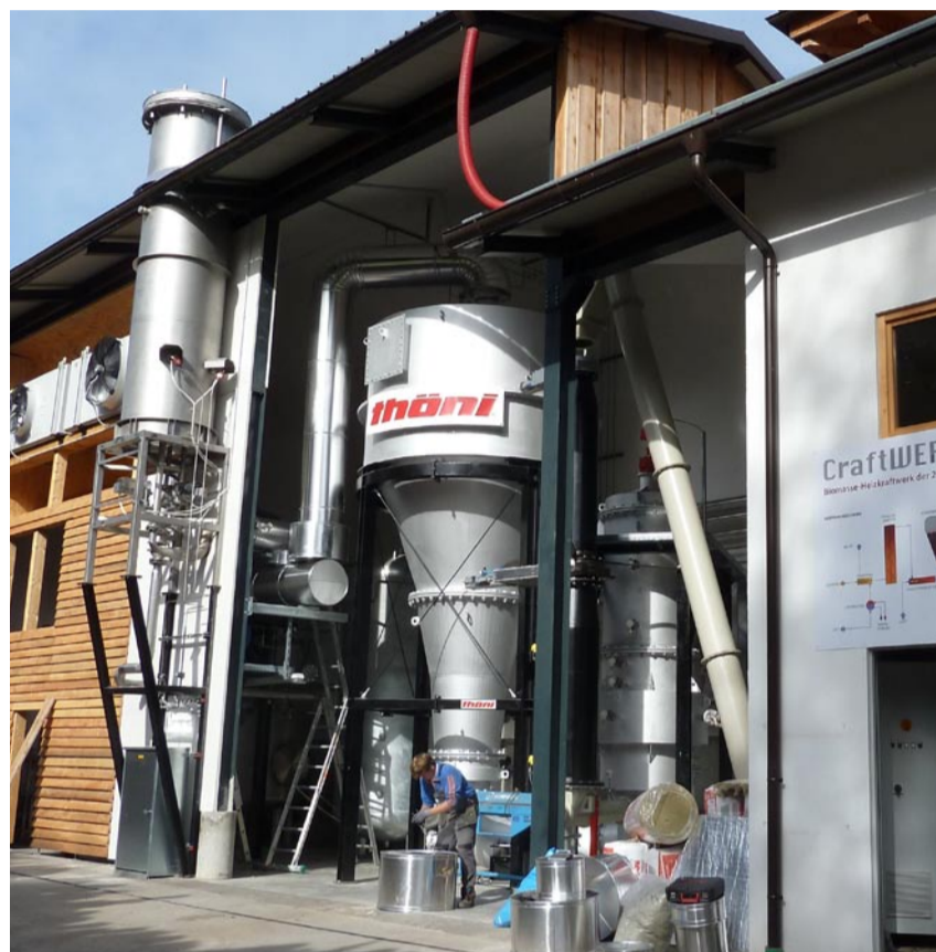
Die Thöni Industriebetriebe GmbH hat das Biomassekraftwerk in Innichen in gerade einmal sechs Monaten Bauzeit errichtet.
